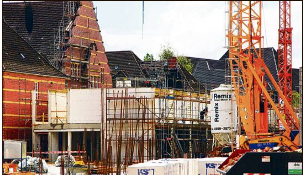
Im Juli 2012 war das Fundament der Anbauten bereits gelegt und die Wände wuchsen in die Höhe.
