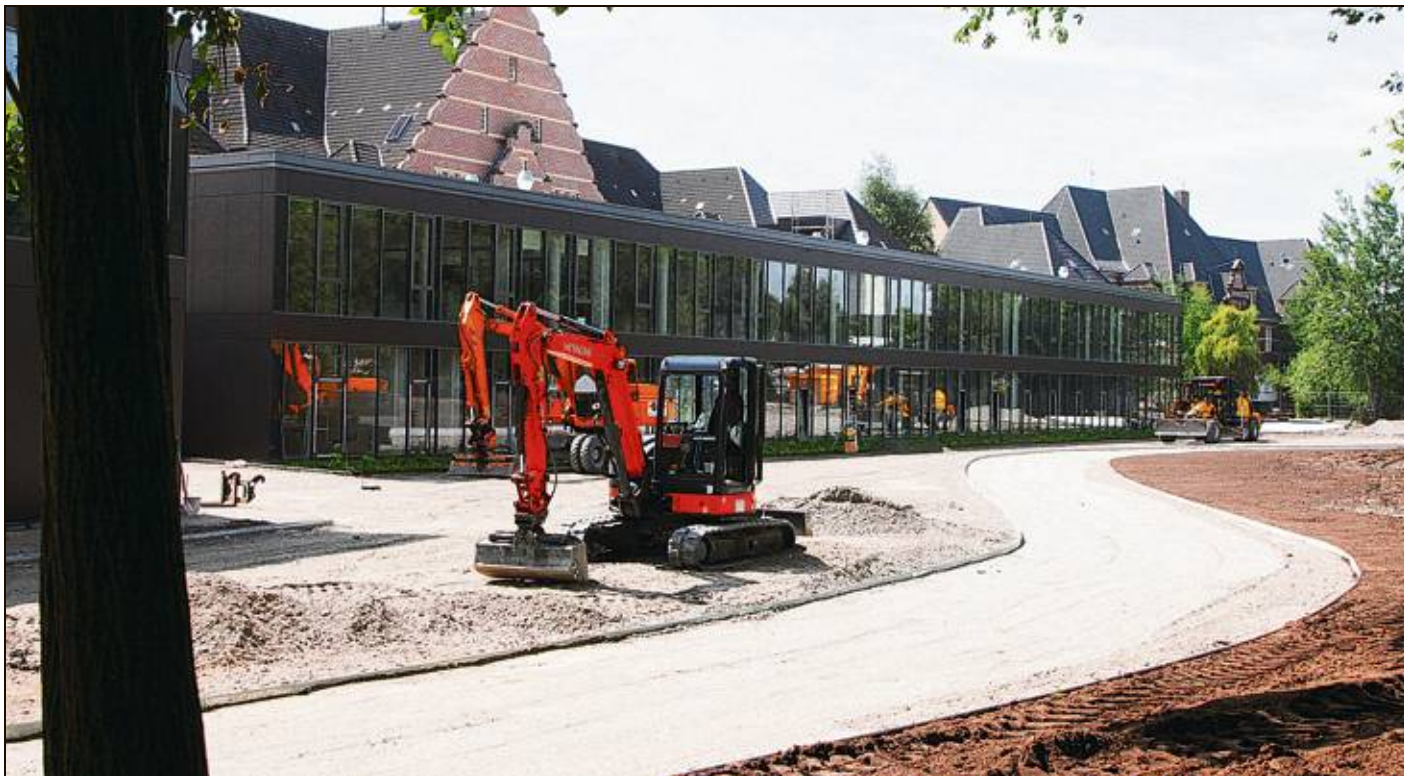
Wegebau auf dem Schulgelände Anfang August. Mittlerweile grünt der Rasen, und in Kürze können die Schüler in den pausen auf den gesamten Freiflächen toben.
